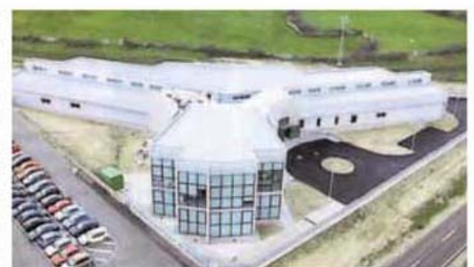
▲ Obras recientes. Entre los últimos trabajos de Priasa se encuentran, de arriba a abajo, el almacén de Hislavor, en Tordesillas (Valladolid), la fábrica de Entrepinares, en Valladolid o el edificio I+D de Grupo Siro en El Espinar (Segovia). :: EL NORTE
