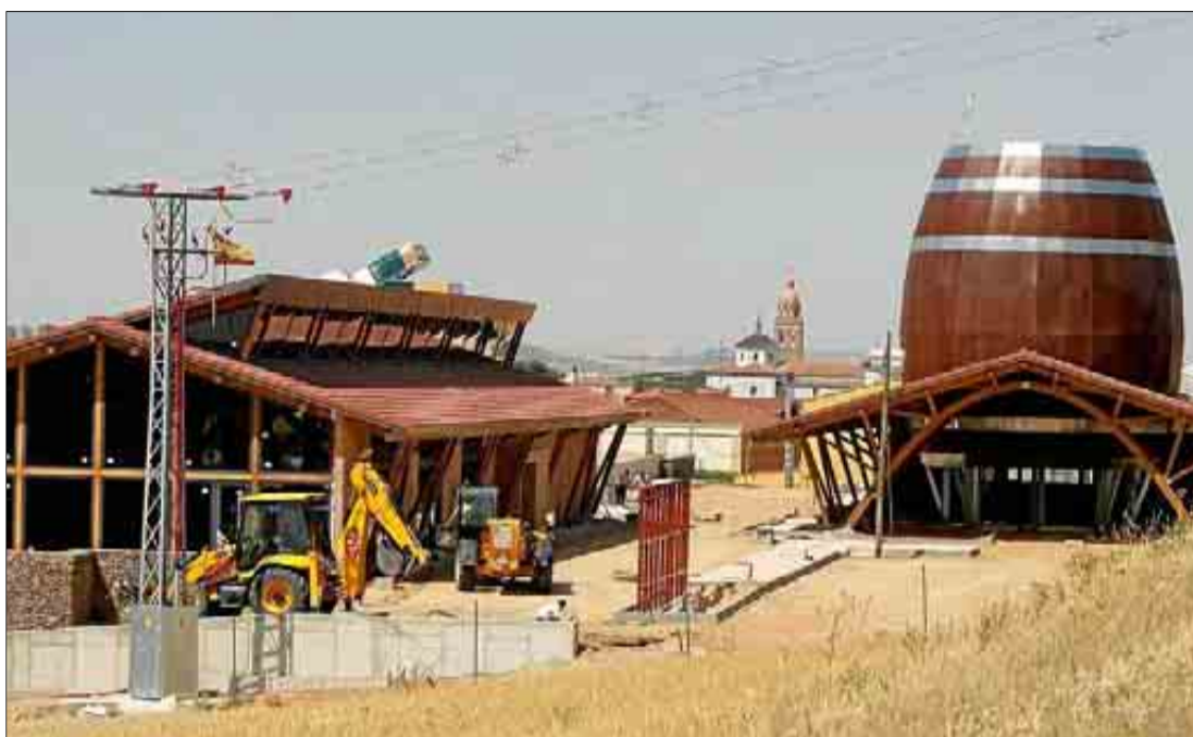
Estado de las obras de la nueva sede de Agrícola Sanz con la cuba de 15 metros y 40 toneladas. / J. M. LOSTAU
